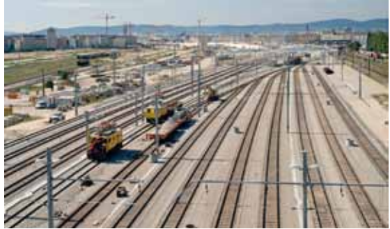
Anlage Ost Gleisbau
