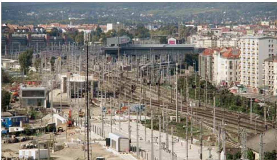
Anlage Süd – Betriebsgebäude/Wasseraufbereitung, Trafostation, LS-Wand, Oberleitung
