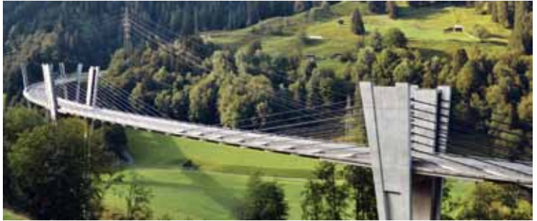
Sunnibergbrücke bei Klosters, Schweiz
