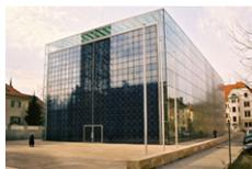
Die Herz-Jesu-Kirche in München gilt europaweit als einzige große geklebte Fassadenkonstruktion aus tragendem Glas. Das Seminar informiert über die baurechtliche Einordnung geklebter Konstruktionen sowie Materialprüfungen im Zusammenhang mit Verklebungen mit Silikon. Veranstalter sind die Baylka-Bau,
